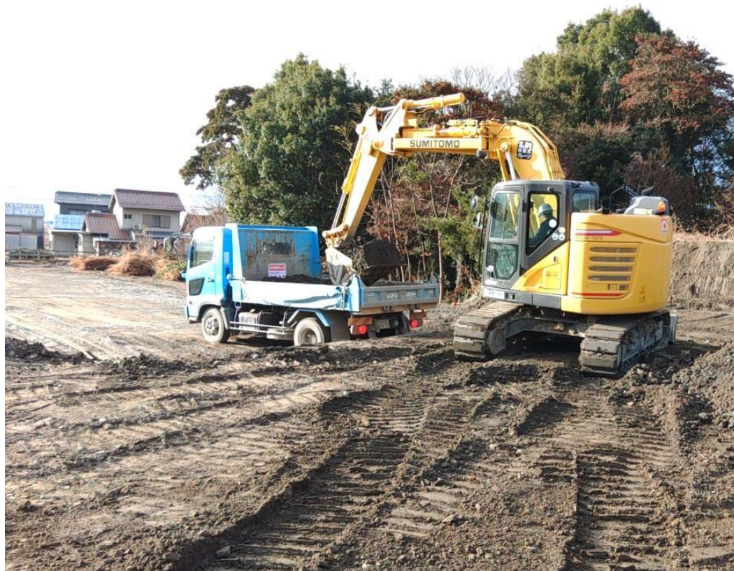
建設発生土の搬出状況
