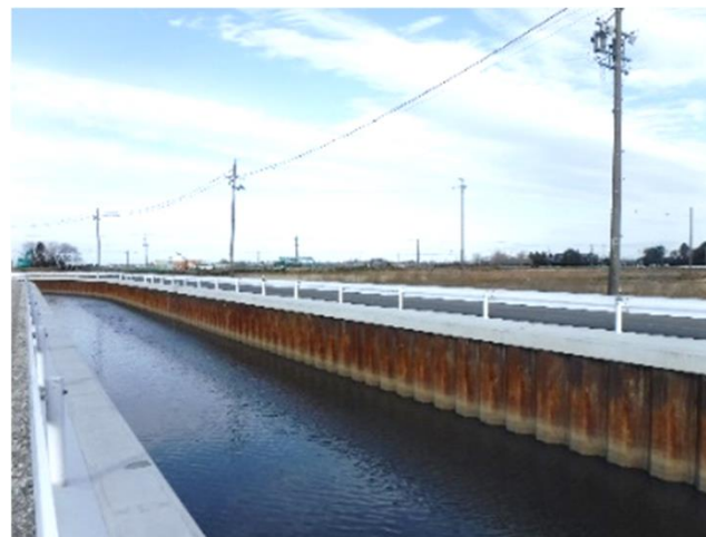
鋼矢板護岸排水路（改修後）
