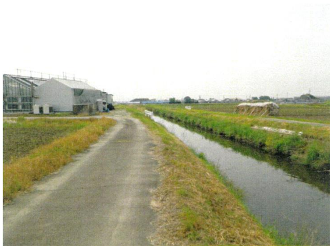
コンクリートブロック積護岸排水路（改修前）
