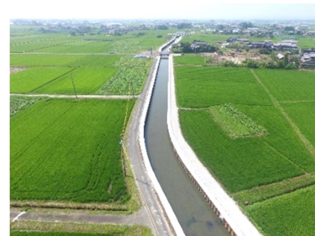
排水路前景（改修後）
