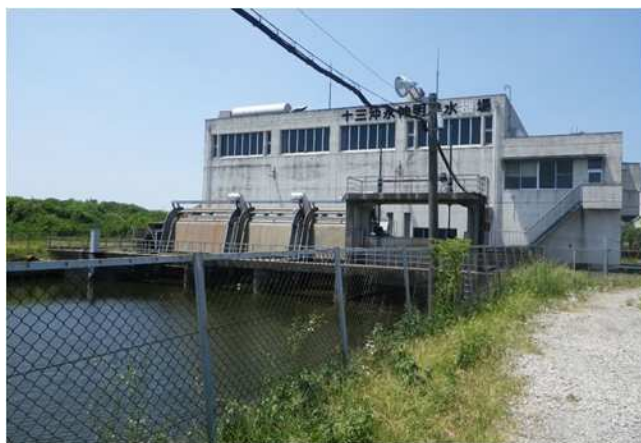
十三沖永神明排水機場(廃止)
