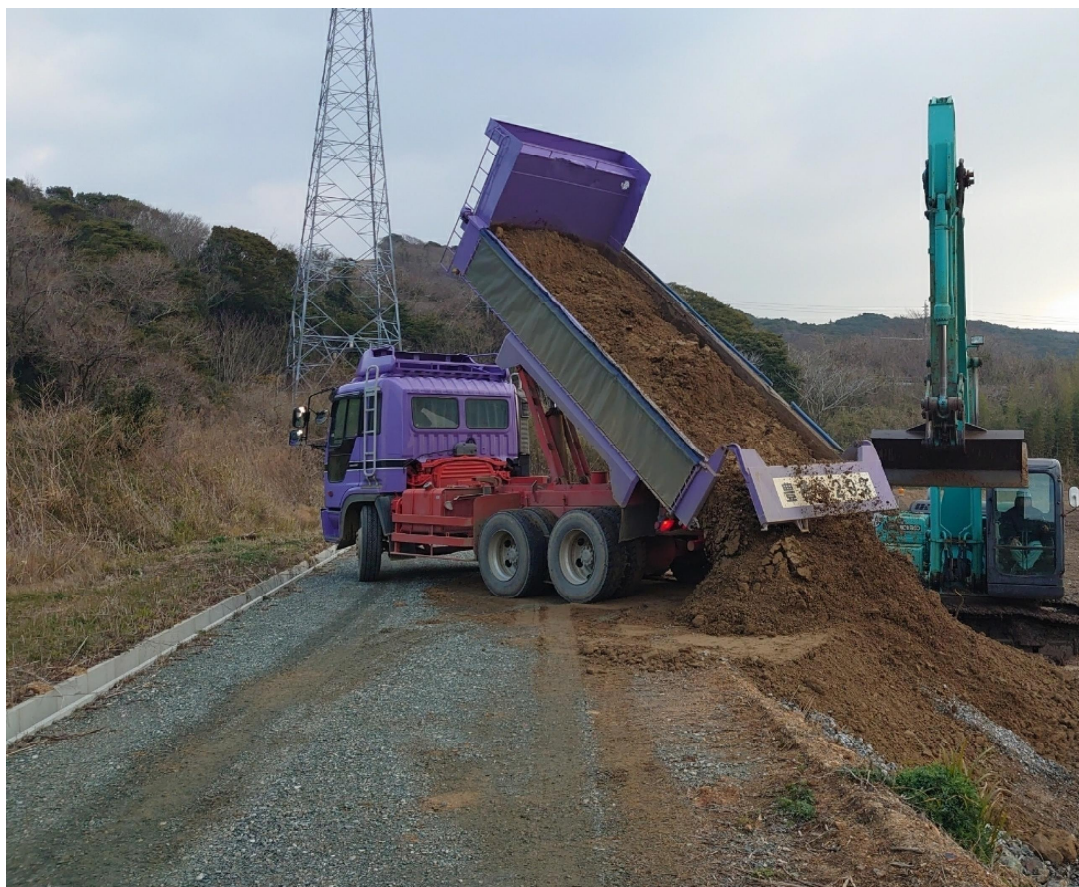
他地区へ発生土運搬状況
