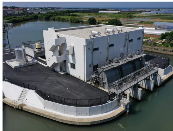
新天白排水機場（新設）
