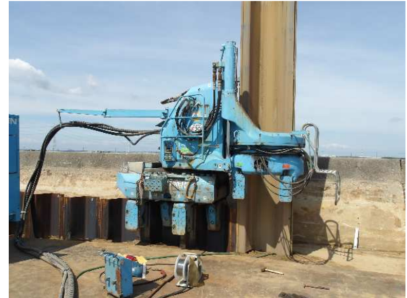
ハット型鋼矢板打設状況(中根樋門)
