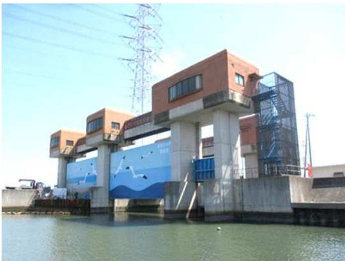
北浜川排水樋門
