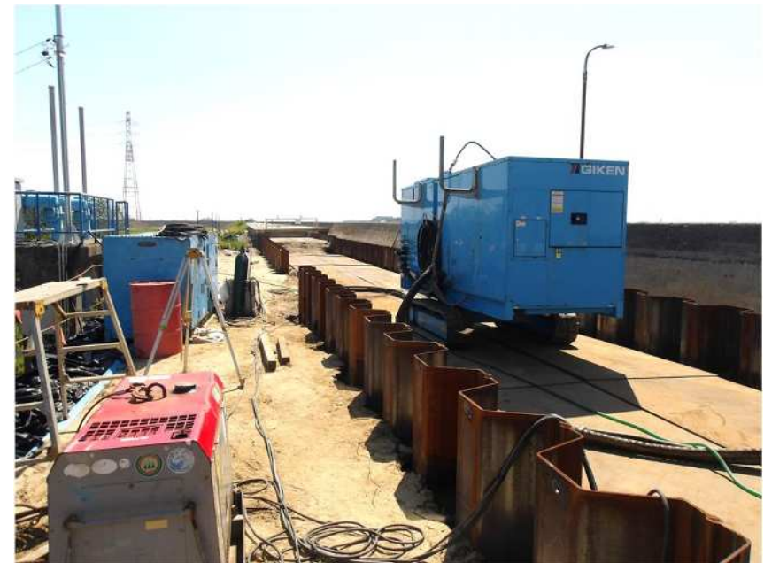
鋼矢板打設状況(中根樋門)
