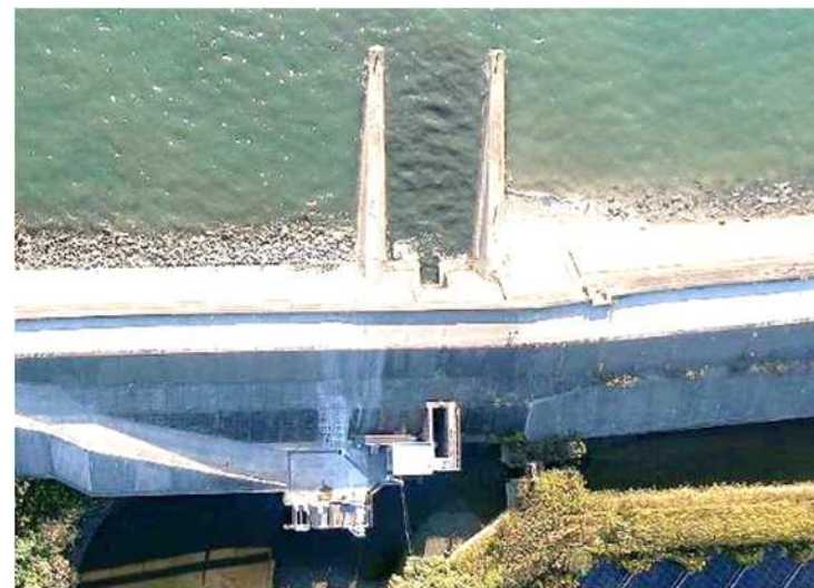
西実録第2樋門
