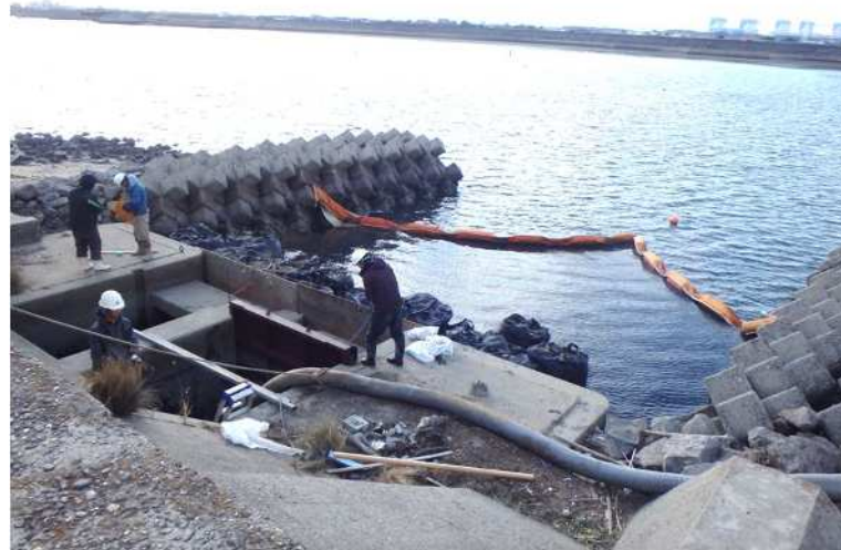
濁水防止フェンス設置
