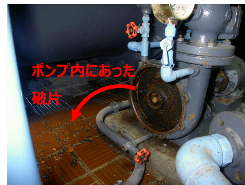
注水ポンプ分解
