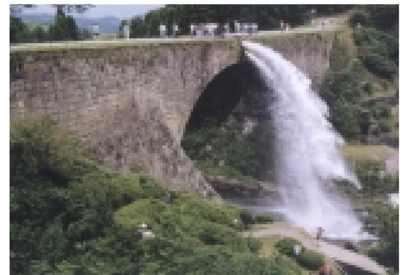
通潤橋 (熊本県矢部町) 「水不足の大地に命のかけ橋を」という民衆の願いが生んだ、江戸時代後期の土木技術の最高傑作といわれる農業水利施設。長さ76m、高さ20mで、その中にサイホンの原理を応用した独創的設計による3本の通水管を通しています。
