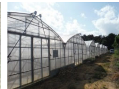
【農業用ハウスの整備】
