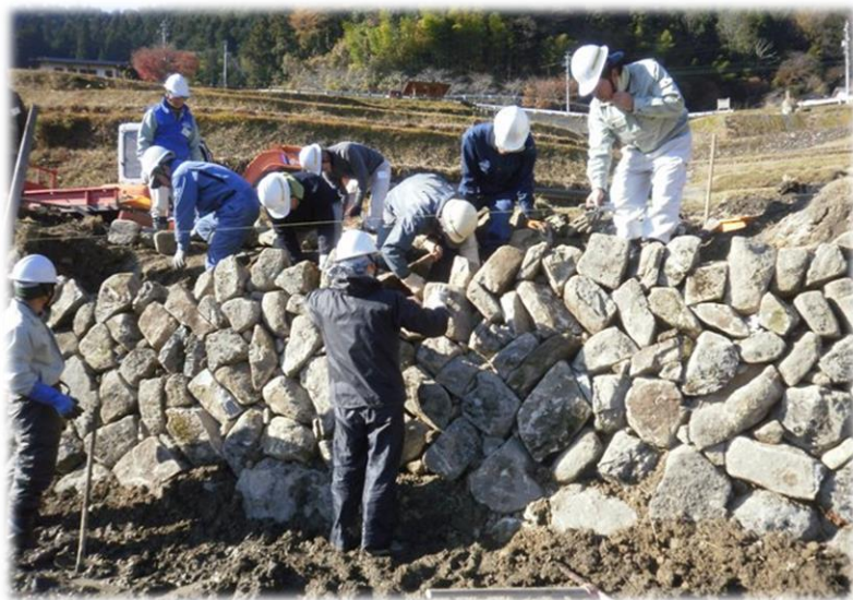
「石積み塾」石垣の補修
