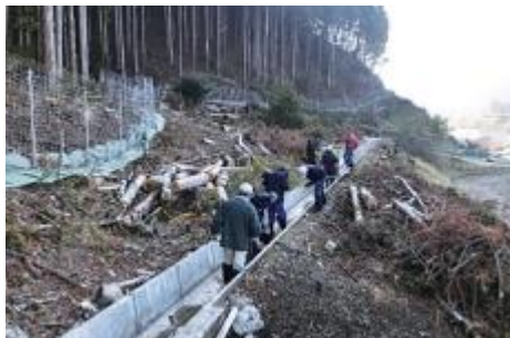
水路の泥上げ
