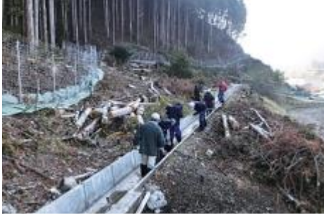
水路の泥上げ
