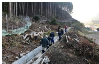
水路の土砂上げ
