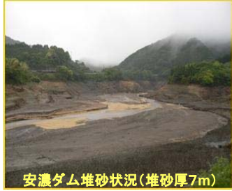
安濃ダム堆砂状況(堆砂厚7m)
