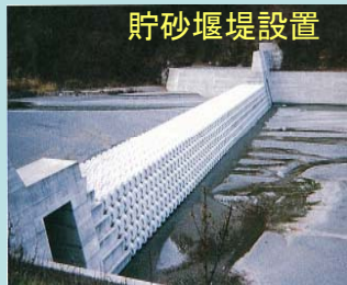
堰堤による土砂流入抑制
