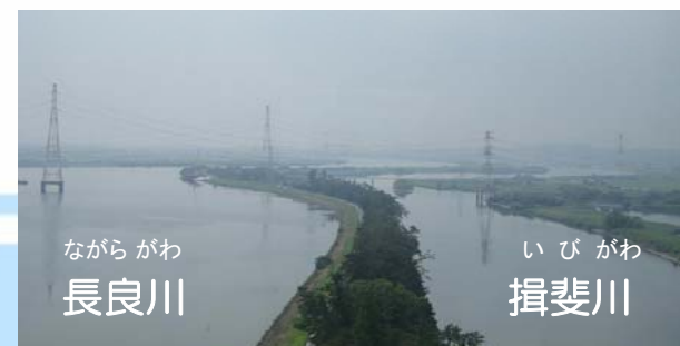
ながらがわ いびがわ 長良川 揖斐川 ていぼう ぶんりゅう ながらがわ いびがわ 堤防で分流された長良川と揖斐川
