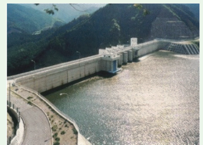
安濃ダム全景
