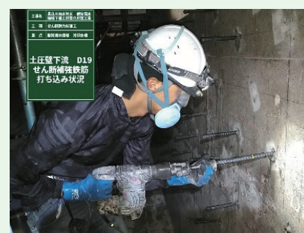
せん断耐力補強工 鉄筋打込状況
