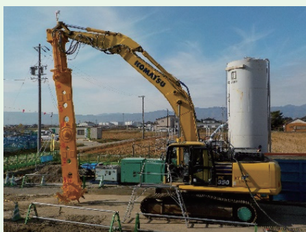
地盤改良工 WILL工法
