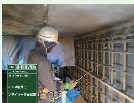
曲げ耐力補強工 PCM増厚工塗布状況
