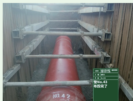
軽量鋼矢板土留工法 ALW管布設状況
