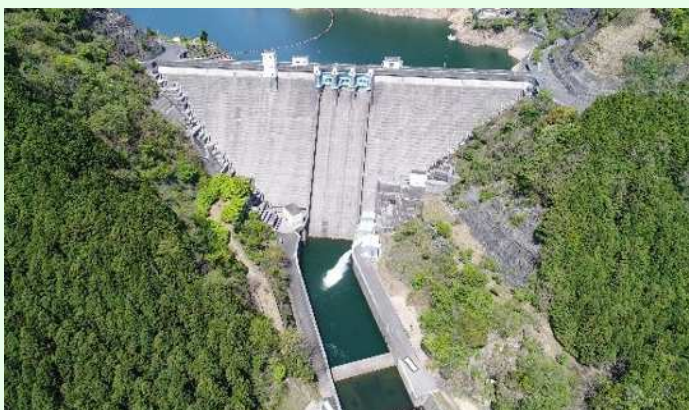
安濃ダム全景
