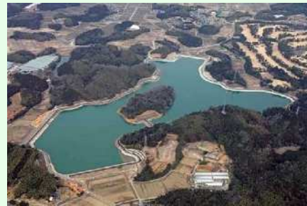
斎宮調整池全景
