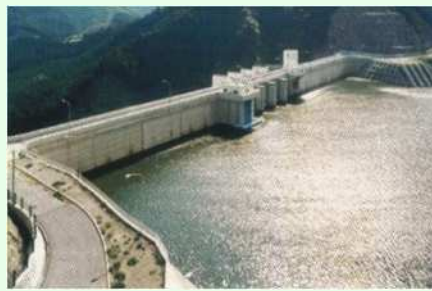
安濃ダム全景
