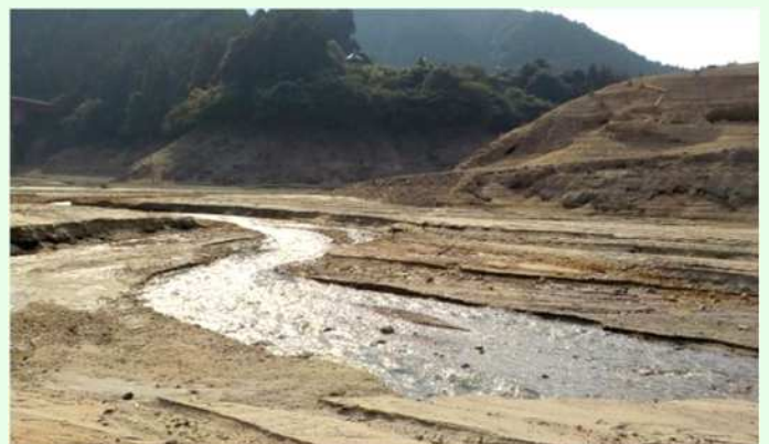
ダム貯水池内堆砂状況
