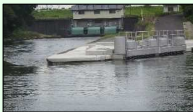
小水力取水ゲート付近から取水樋門迄の状況
