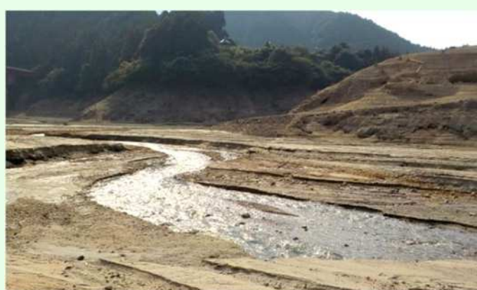
ダム貯水池内堆砂状況
