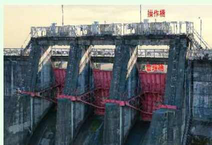
羽布ダム洪水吐ゲート
