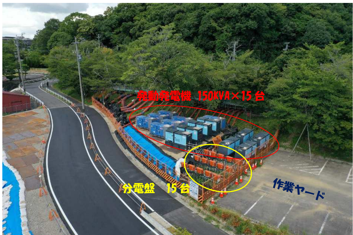
発動発電機(150KVA×15台)設置イメージ
