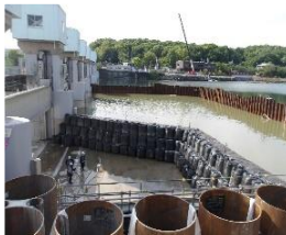
連続箱型鋼製枠(完成)
