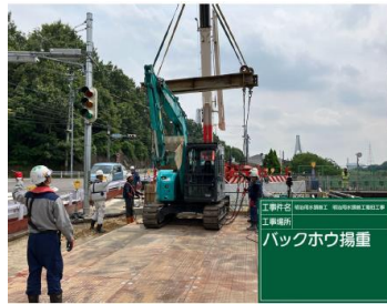
バックホウ本体に損傷なく揚重できる専用吊り具
