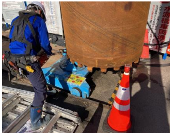
パイルローラ(横揺れ防止治具)による安全かつ確実な鋼管杭建込作業の実施
