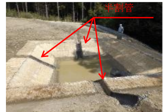
半割管による沈砂池法面浸食対策
