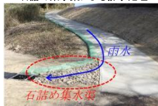
石詰め集水渠による排水処理
