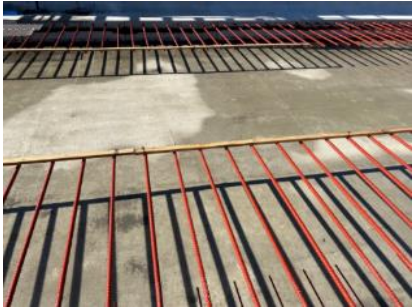
防錆対策・鉄筋先端の曲がり防止措置
