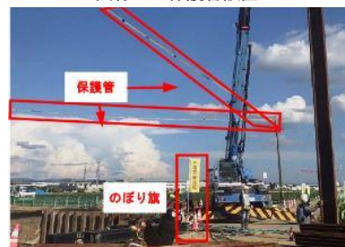
支線への保護管設置
