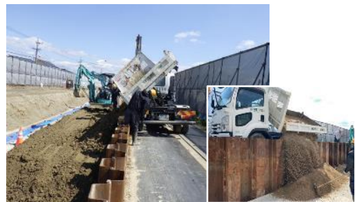
3転ダンプトラックによる埋戻土の投入
