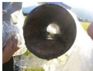
〔暗渠管内部への土砂堆積〕
