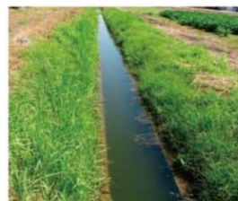
〔水位が高い例（暗渠出口が水没）〕
