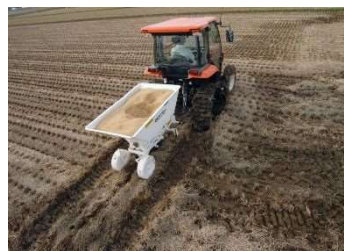
〔弾丸暗渠施工と併せたモミガラ しんせつ の充填状況〕
