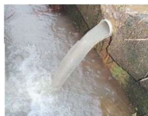
〔土砂排出状況〕
