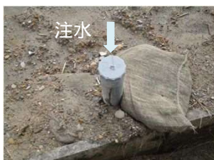
〔立ち上がり管への注水〕
