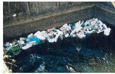
整備前の状況 （羽島用水路）
