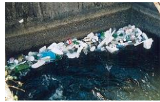
整備前の状況 （羽島用水路）
