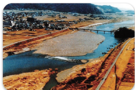
岡島頭首工着工前の状況 (昭和40年当初)
