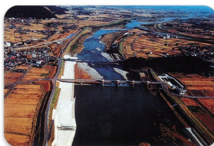
岡島頭首工の完成状況 (昭和51年)
