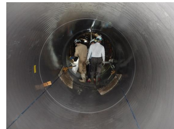
水路トンネルの坑内 （シールド工法）
