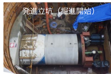
用水路の河川横断工事（推進工法による掘削）
