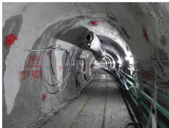
水路トンネルの新設工事 （発破工法による掘削）
