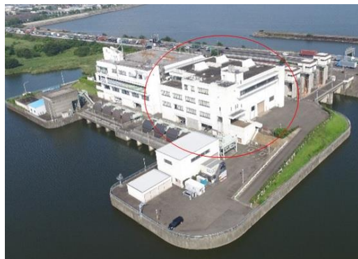
日光川河口排水機場
