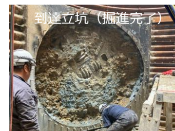
用水路の河川横断工事（推進工法による掘削）
