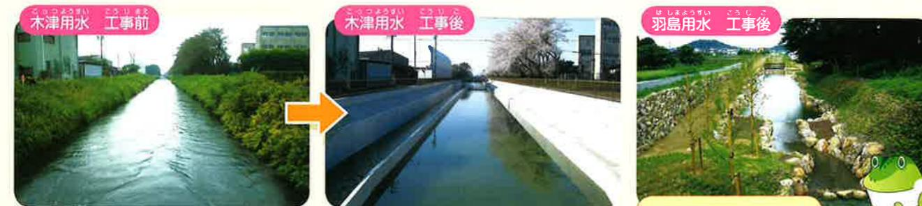
左の写真は、以前の木津用水。川から取った水を農地まで運ぶ用水路と、周辺の田んぼや家庭から出された水を川へと流す排水路が、別々の水路として改修され、きれいな水を下流まで送り続けることができるようになりました。右の羽島用水も同じような工事が完成しており、宮田用水も平成20年度から改修工事が始まっています！
