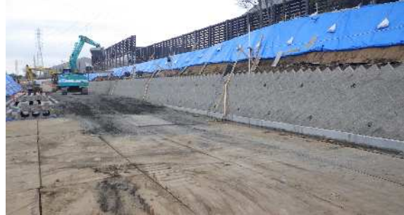
両岸のブロックを積み上げているところです。
