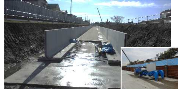
右下の写真はリフト台車でL形製品を搬送しているところです。
