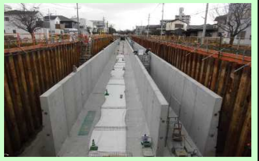
水路工事状況
