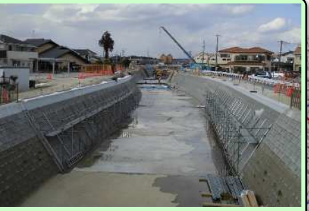
水路工事状況
