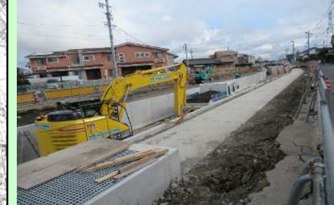
水路工事状況
