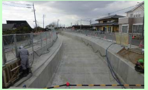
水路工事状況
