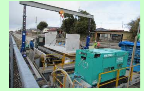
水路工事状況
