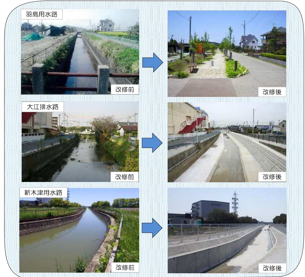
—国営新濃尾土地改良事業における改修の様子—
