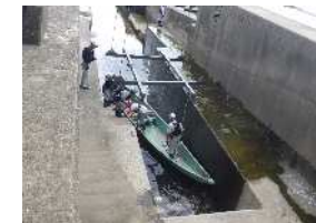
舟通しクレーン
