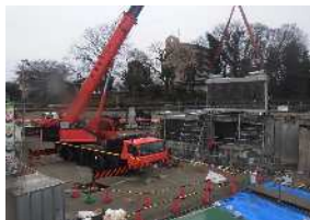
除塵設備の据付
