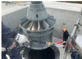
水中タービン発電機の吊り込み
