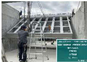
入ロゲートの据付
