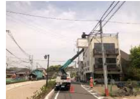
光ケーブルの敷設
