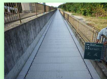
側水路蓋掛後
