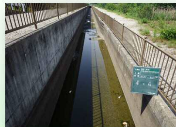
側水路蓋掛前
