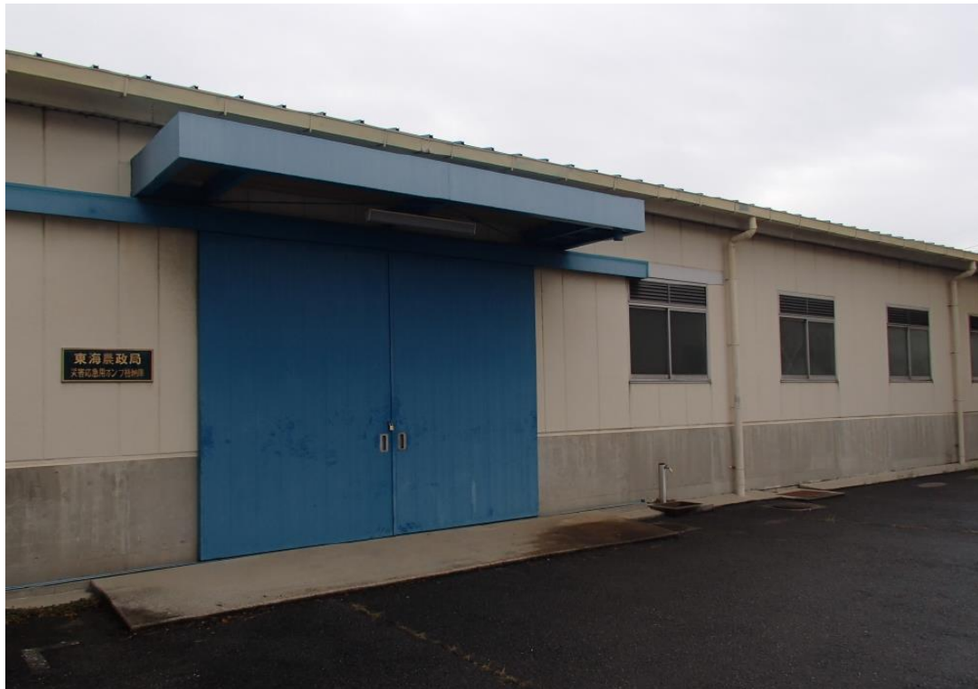
災害応急用ポンプ格納庫全景
