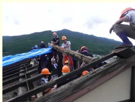
大学生が協力して屋根の大改修
