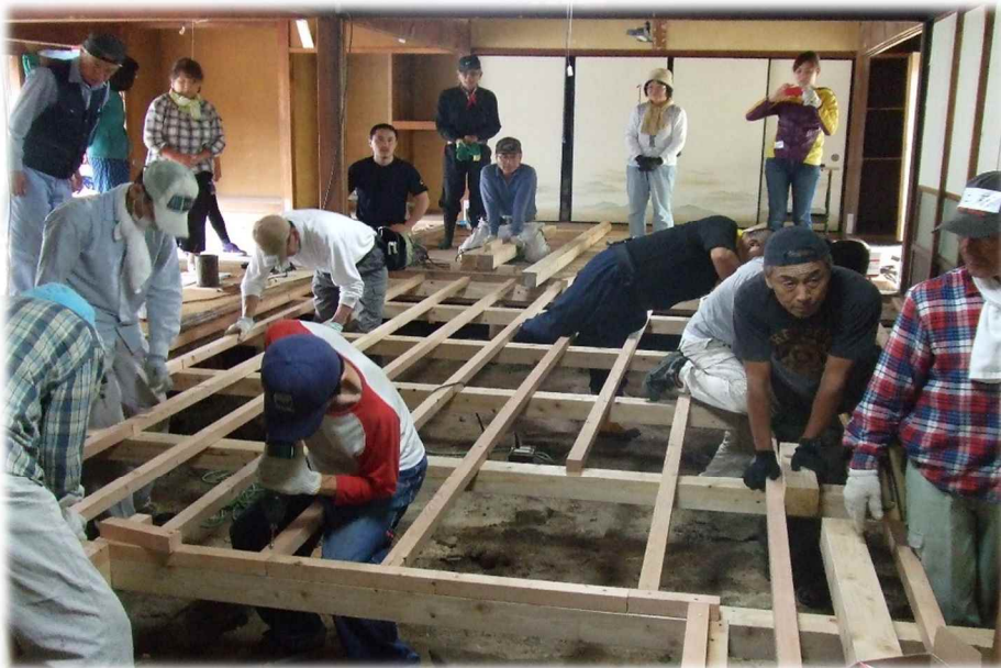
古民家リフォーム塾～床下の改修～
