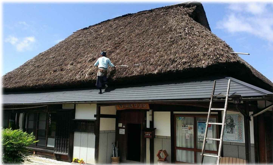
茅葺き職人による茅葺き整備
