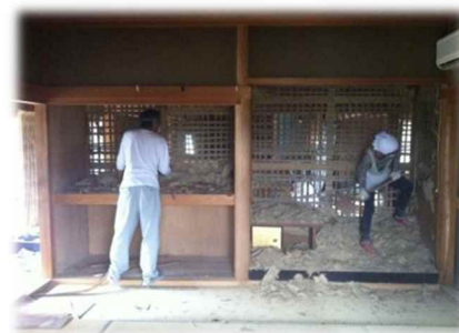
古民家改修作業の様子
