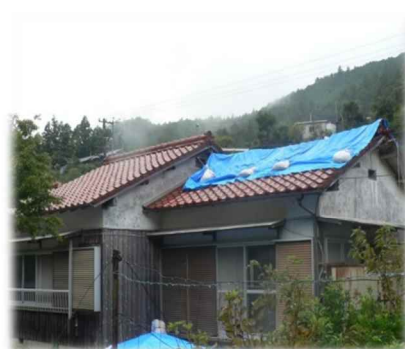
改修前の古民家
