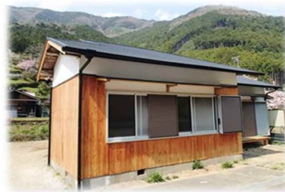
改修後の古民家
