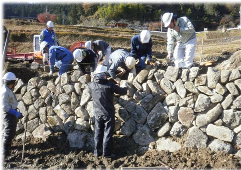
「石積み塾」石垣の補修
