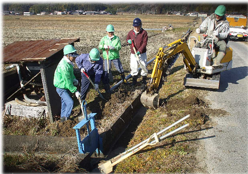
用水管敷設工事を実施
