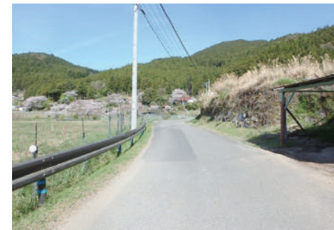
平成23年9月紀伊半島大水害(台風12号) 復旧後の様子
