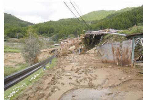
平成23年9月紀伊半島大水害(台風12号) 被災直後の様子
