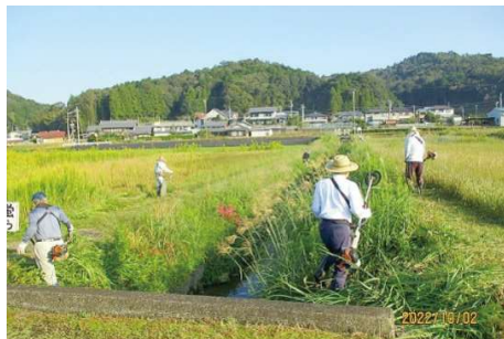
法面の草刈り
