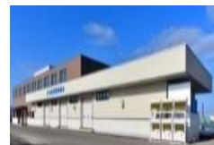
集出荷・貯蔵・加工施設の整備
