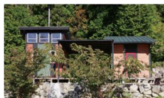
Kiidake/木だけで造る小さな家
