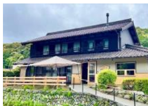
古民家を宿泊施設に改修
