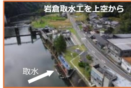
このうち最上流部の基幹的な施設である岩倉取水工については、耐震化対策を既に完了しています。また、北部幹線水路は、農業用水のほか、上水・工水を供給しており、断水が困難であるため、工事に当たっては、用水を一時的に迂回（仮廻し）させる必要があります。そのため、バイパス水路として、北部幹線「併設」水路を新たに造成する計画としています。
