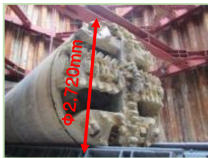
到達立坑に達したシールドマシン※
