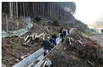
水路の土砂上げ
